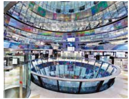
Zwölf Kegel und Zylinder aus Glas geben dem Gebäude eine besondere Eleganz und Leichtigkeit.
