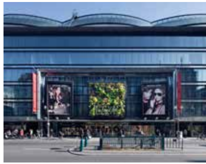
Ein vertikaler Garten schmückt einen Teil der Glasfassade in der Friedrichstraße.
